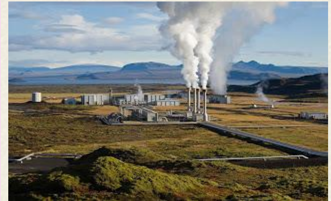
Pembangkit Listrik Tenaga Panas Bumi
