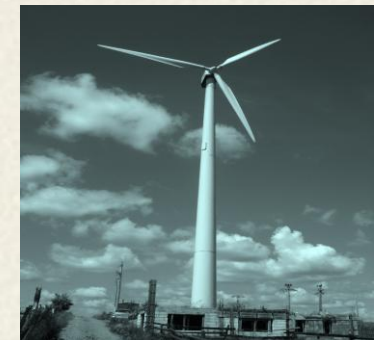
Pembangkit Listrik Tenaga Angin
