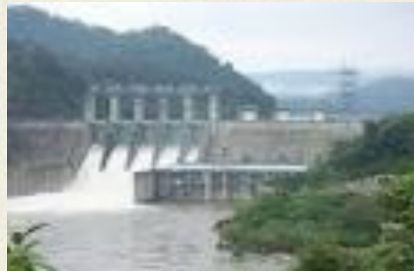
Pembangkit Listrik Tenaga Air
